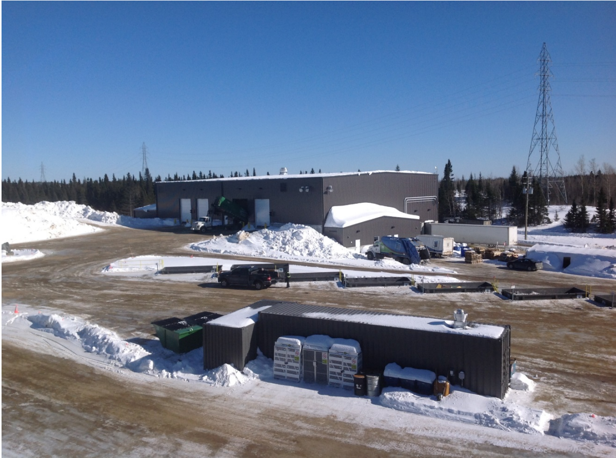
Écocentre et centre de transfert de Baie-Comeau (Source : RGMRM)
