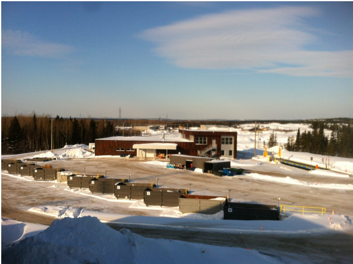
Complexe de gestion des matières résiduelles de Manicouagan (CGMRM) (Source : RGMRM)
